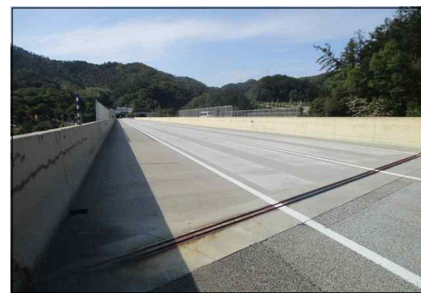
조양교(양양) 상부 전경
