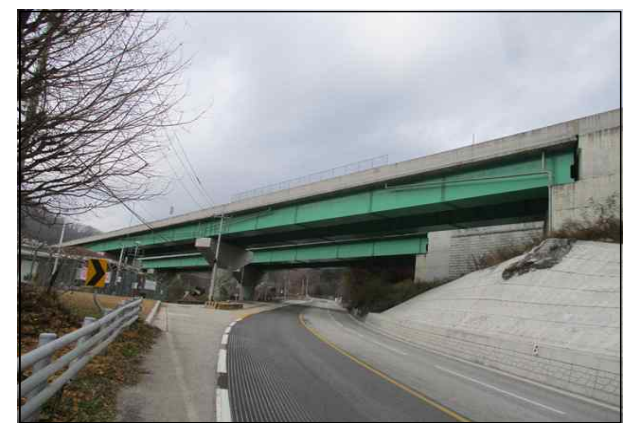
조양교(양양) 측면 전경
